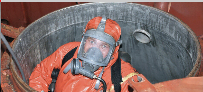
Limpieza y desinfección de tanques de agua potable.
